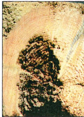
Untersuchung mit dem Bohrwiderstandsmeßverfahren unterzogen. Wichtig war hierbei, zu klären, ob sich die vorliegende Querschnitts- und Tragfähigkeitsminderung nur auf den Mauerbereich reduziert oder bis in den Innenraum der Kirche erstreckt. Letzteres hätte bei der Sanierung einen Eingriff in das sichtbar bemalte Holz zur Folge.
